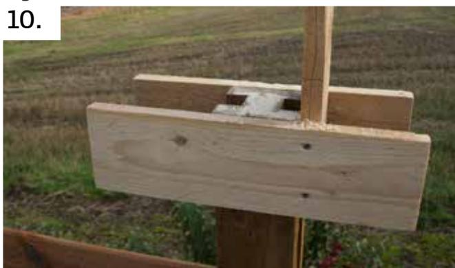
Als Hilfe können Sie sich eine Schneidelade aus drei Holzstücken mit einer Kante zusammenschrauben, in der Sie die Säge führen können. Wenn alle Pfosten zurecht gesägt sind, setzen Sie das letzte Zaun-Profil ein und schrauben Sie es fest. Denken Sie daran, dass die oberen Profile zwei Schrauben an jedem Ende benötigen.
