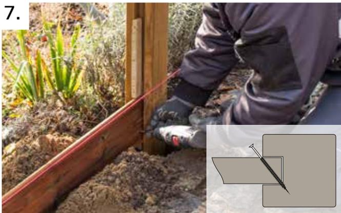
Nun können Sie das erste Profil fest verschrauben. Beginnen Sie an der Unterseite des Zaunes. Verwenden Sie eine 4,0 x 60 mm. Schraube. Es sollten mindestens 4 cm zwischen Profil und Erde eingehalten werden. Alle Profile werden mit einer Schraube an jedem Ende befestigt.
