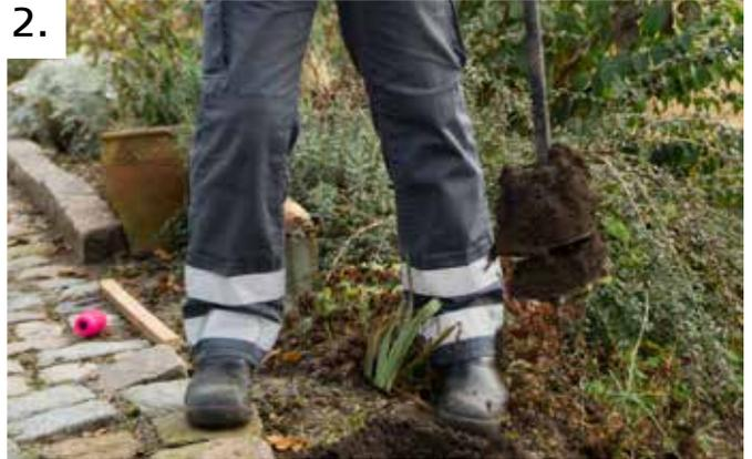
Finden Sie zuerst heraus, wo der erste Pfosten platziert werden soll, damit der Pfosten stabil steht. Bohren oder graben Sie das erste Loch 80 bis 90 cm tief. Stellen Sie sicher, dass der Pfosten gerade steht, bevor Sie das Loch mit Erde füllen (falls erforderlich, den Pfosten in Beton gießen).
