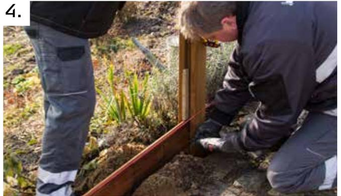
Platzieren Sie den nächsten Pfosten. Verwenden Sie ein Zaun-Profil um den genauen Abstand einzuhalten. Heben Sie ein neues Loch aus und platzieren Sie den nächsten Pfosten auf die gleiche Weise wie in Punkt 2. Schrauben Sie das obere und untere Profil mit einer temporären Schraube fest.
