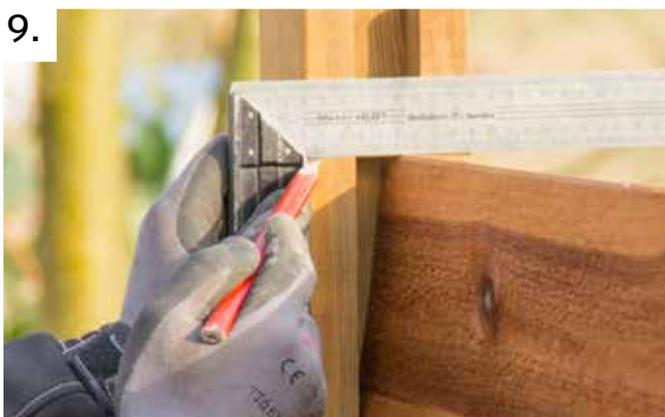
Wenn alle Profile platziert sind, werden die Pfosten in der richtigen Höhe gekürzt. Markieren Sie die Pfosten an der Spitze mit einem Winkel und entfernen Sie das oberste Profil. Nun sägen Sie die Pfosten unterhalb der Oberkante des oberen Profils auf 1,5cm ab.
