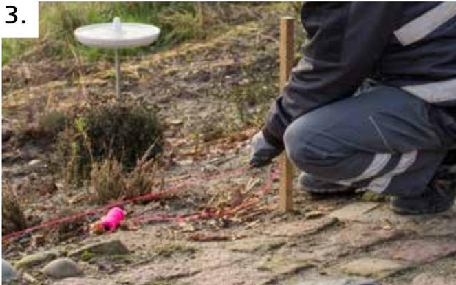
Wenn der erste Pfosten gesetzt ist, platzieren sie einen Stab in der Flucht mit dem Zaun und ziehen Sie eine Schnur vom ersten Pfosten zum Stab. Somit stellen Sie sicher, dass die darauffolgenden Pfosten in einer geraden Reihe platziert werden.
