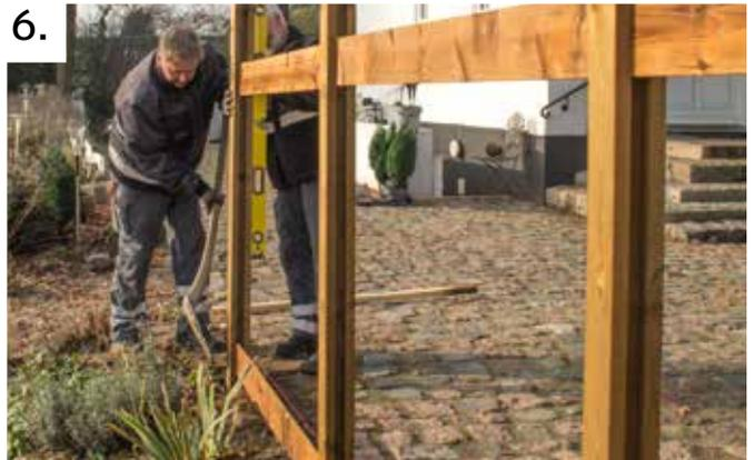
Um alles zusammen zu halten, platzieren Sie die restlichen Pfosten mit dem oberen und unteren Profil auf die gleiche Weise wie zuvor beschrieben, bis alle Pfosten auf ihrem Platz stehen. Zum Schluss können Sie die mittleren Profile montieren.
