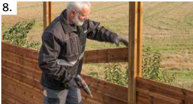
Montieren Sie den Rest der Profile. Die unteren und oberen Profile müssen mit zwei Schrauben an jedem Ende befestigt werden, während die mittleren Profile mit einer Schraube an jedem Ende befestigt werden. Nasse Profile sollten eng aneinander befestigt werden, während trockene Profile mit 2-3 mm Luft zwischen Feder und Nut befestigt werden sollten, damit diese sich ausdehnen können.
