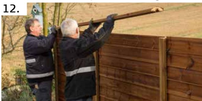
Jetzt fehlt nur noch die Montage des Abschlussprofils. Am schönsten sieht es aus, wenn das Profil 1-2 cm über die Enden ragt. Markieren Sie die Mitte des Pfostens dort, wo das Abschlussprofil gesägt werden soll. Das Abschlussprofil wird mit zwei Schrauben an jedem Pfosten montiert. Wenn Sie das Spalten der Profile vermeiden möchten, ist es eine gute Idee, Löcher für die Schrauben vorzubohren.
